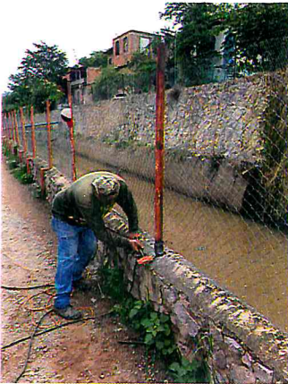
SOLDAR Y REFORZAR PROTECCION DEL CANAL POR CARMEN SERDAN
